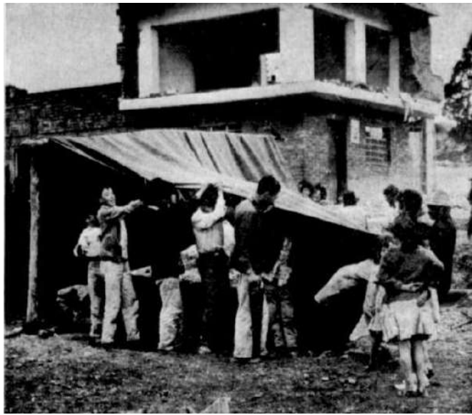
Figura 45. Destrucción del muro de fachada de una vivienda de dos pisos, al sur de Bogotá Fuente: El Tiempo, 1966.
