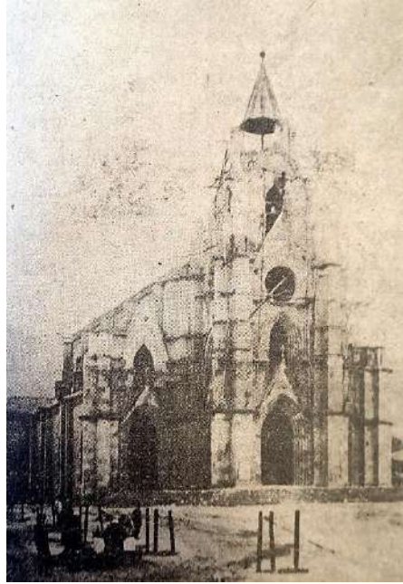
Figura 36. Estado en el que quedó la iglesia de Chapinero (Lourdes) a causa del sismo de 1917 Fuente: El Diario Nacional, 1917.
