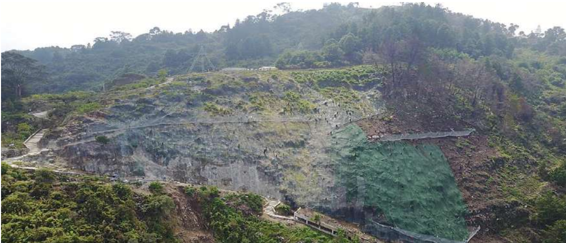
Sector norte sendero peatonal al santuario de Monserrate. Obra ejecutada- Fuente IDIGER
