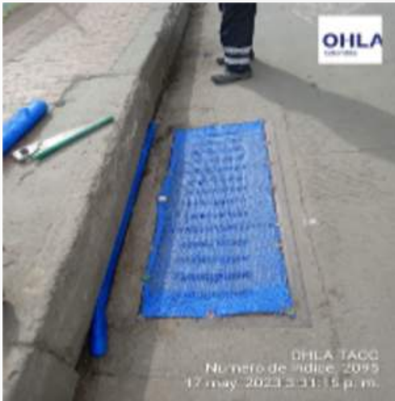
*Limpieza de sumideros
