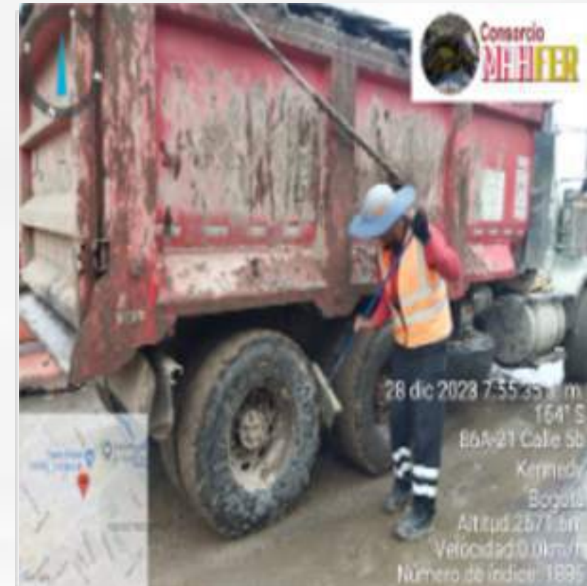
*Limpieza de llantas para evitar el arrastre de material a las vías aledañas de la obra, durante época de lluvias se hace con agua recirculada.
