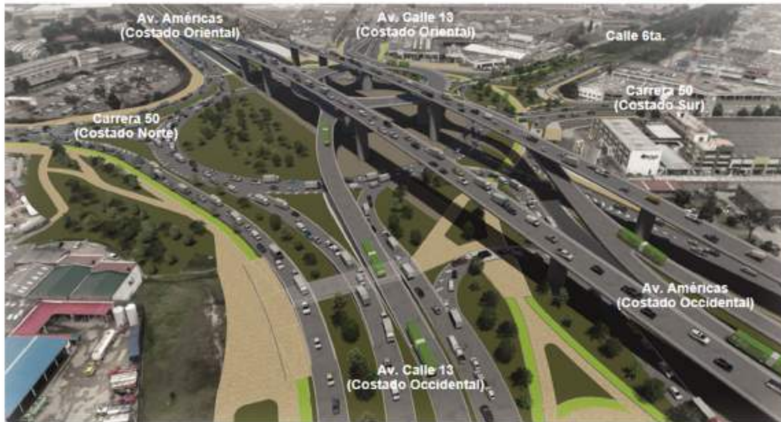
Intersección Puente Aranda
