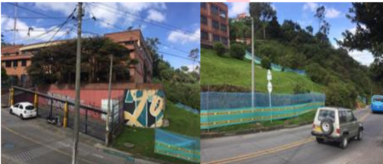
Fotos: Obras en el sector Laches de la Localidad de Santa Fe.
