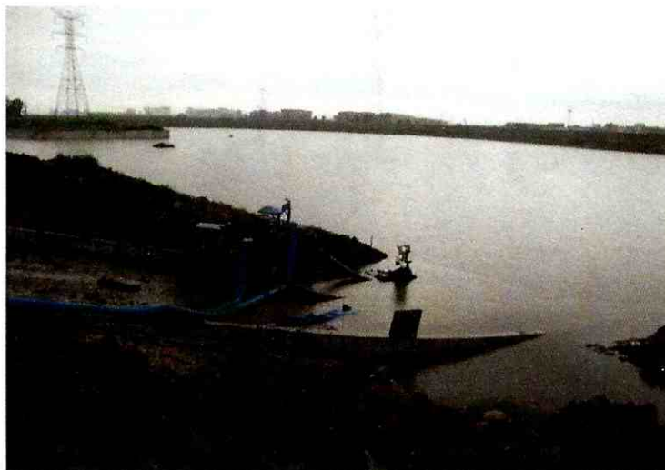
Foto 7. Estaciones móviles de bombeo evacuando el agua del pondaje La Magdalena hacia el Canal Cundinamarca
