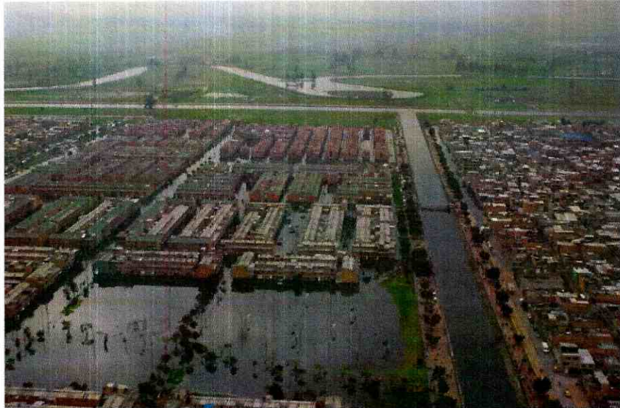
Foto 28. Zona afectada por la inundación en Bosa y altos niveles del canal Tintal III
