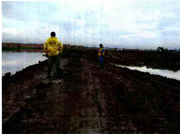
Foto 10. Reconfiguración provisional de un sector del jarillón izquierdo del río Fucha, situación de desbordamiento del río.
