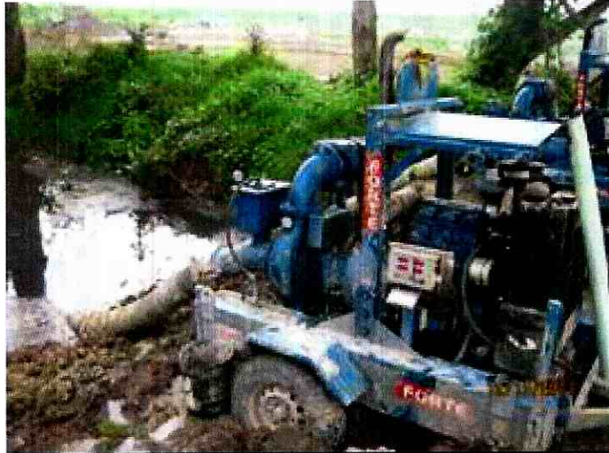
Foto 36. Bombeo desde el canal de descarga de la estación elevadora de Fontibón hacia el río Fucha
