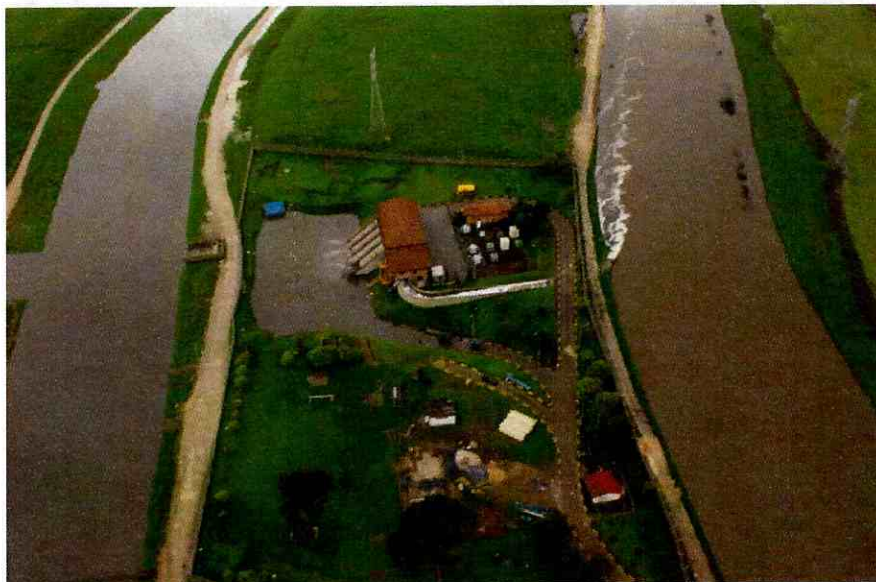
Foto 26. Funcionamiento estación elevadora Gibraltar con condiciones de niveles altos. Diciembre 8
