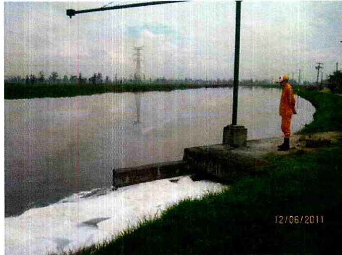
Foto 25. Espuma característica de agua residual en el canal de descarga de la estación elevadora Gibraltar
