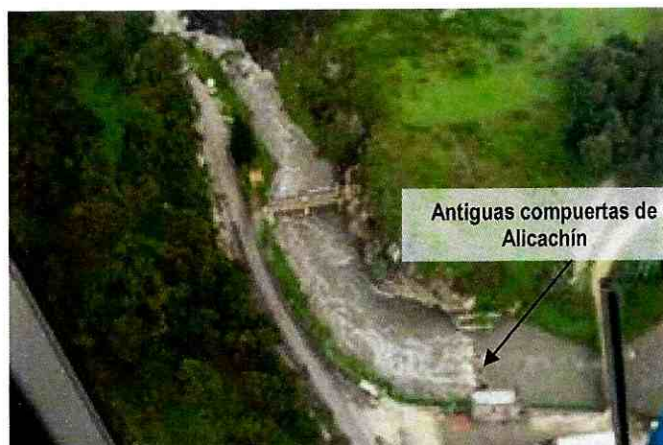
Foto 19. Control hidráulico de las antiguas compuertas de Alicachín sobre el río Bogotá
