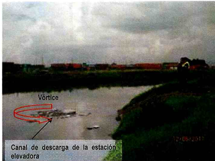
Foto 23. Vórtice de succión del agua desde el río Fucha a través del canal de descarga de la estación elevadora Fontibón
