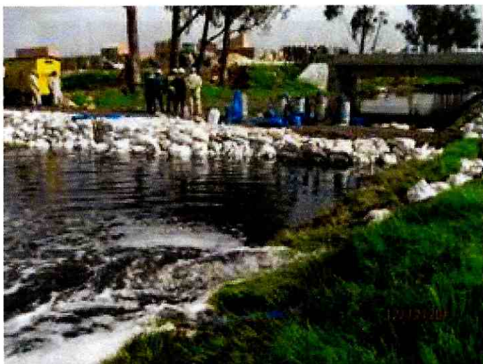
Foto 41. Tambre terminado con bombeo hacia el Canal Cundinamarca
