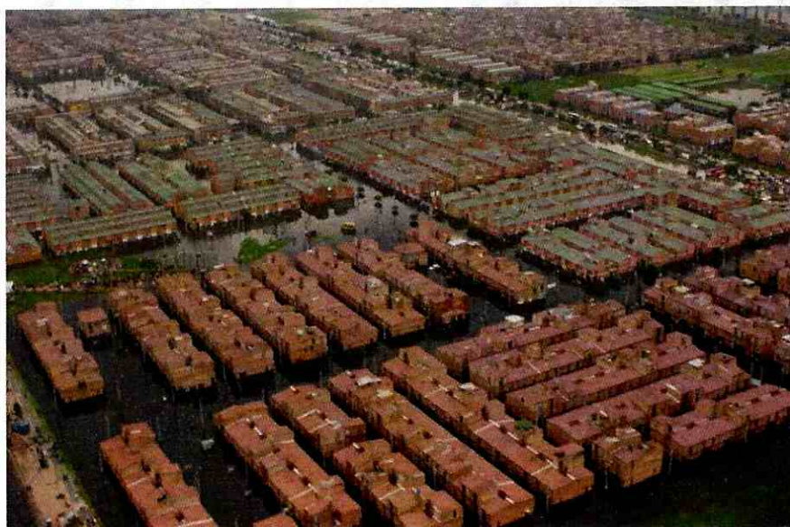
Foto 27. Zona afectada por la inundación en Bosa – Alameda del río
