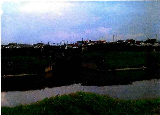
Foto 16. Niveles en el canal Cundinamarca 22 de noviembre. Grupo Gestión Local
