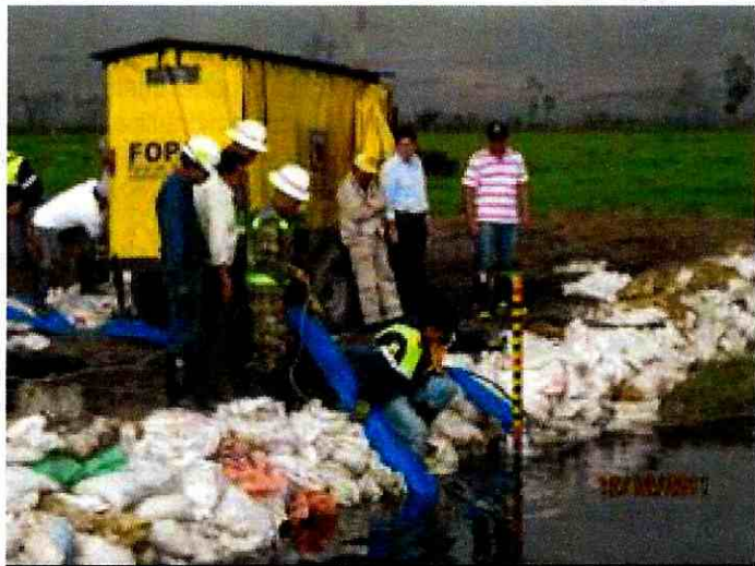
Foto 46. Instalación de bombas sumergibles en el Canal Santa Isabel, suministradas por FOPAE.
