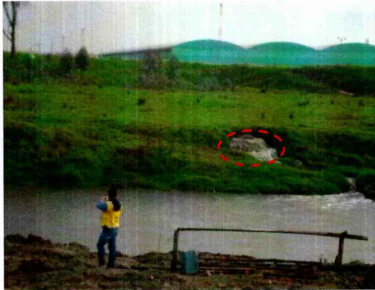
Foto 3. El interceptor Alsacia presurizado y descargando directamente al Canal Cundinamarca.
