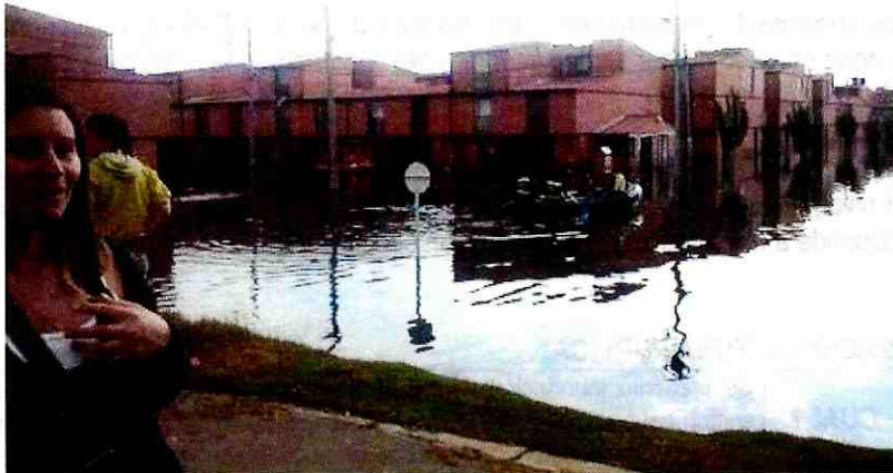
Foto 31. Afectación inundación viviendas por reflujos de canales en Bosa
