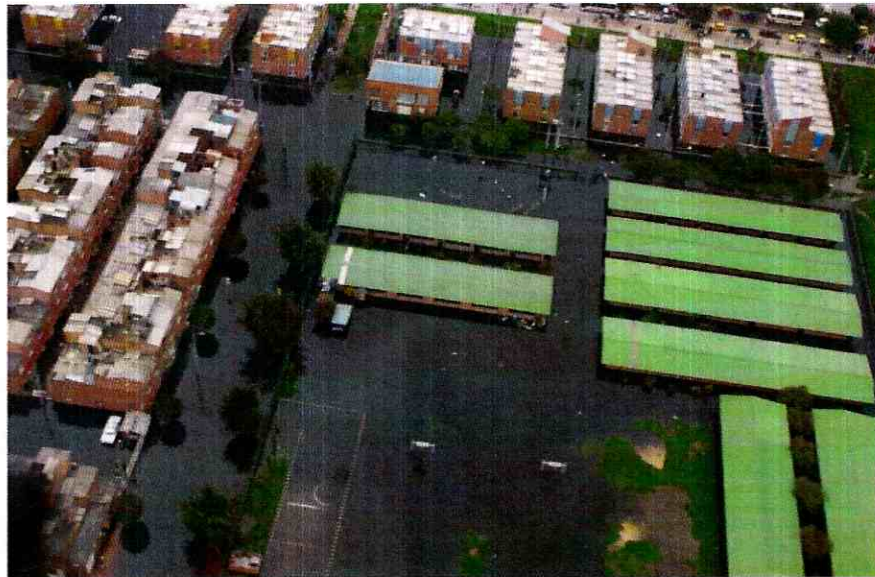
Foto 29. Detalle zona afectada por la inundación en Bosa
