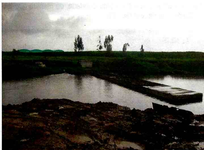
Foto 11. Canal Cundinamarca con altos niveles, construcción del box coulvert y descarga Villa Alsacia
