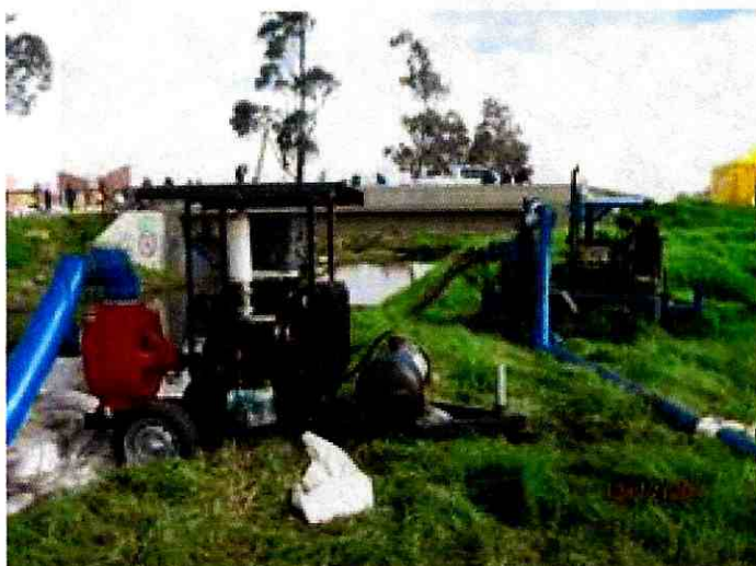
Foto 42. Bombeo desde el Canal Santa Isabel con las dos bombas del Ejército y la EAAB
