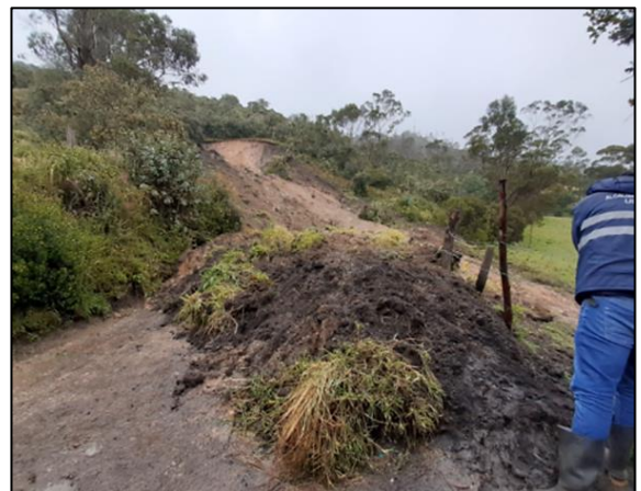
Ilustración 3. Evento por Remoción en Masa – Entrada Vereda Curubital Kilómetro 10+700 Vía Sumapaz– 15 de Noviembre de 2020
