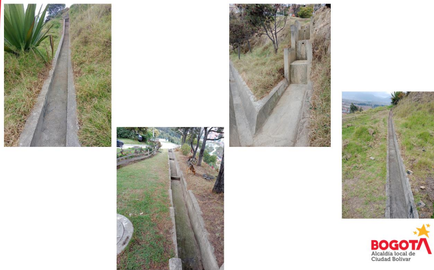
Obras de Mitigación Bonanza Sur
