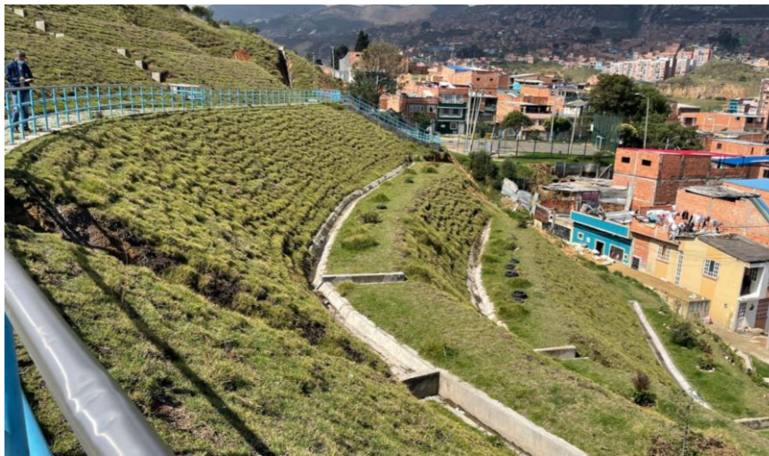
Obra de Mitigación Sotavento
