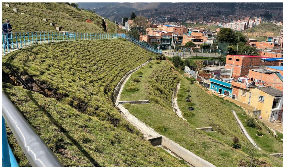
Obra de Mitigación Sotavento
