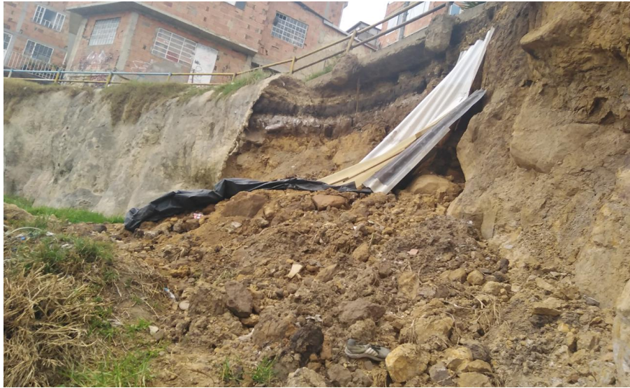
Obra de Mitigación San Isidro Cerritos I
