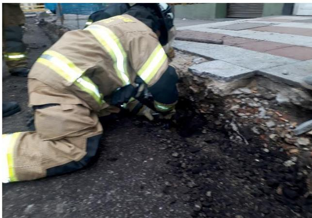
Los trabajos de excavación son realizados por personal técnico calificado, por lo cual de forma accidental perforan los tubos, ocasionando fugas de gas. Otra causa es la falta de señalización de las líneas de gas subterráneas con cinta preventiva, la cual indica que por debajo de la misma pasa tubería de gas.
