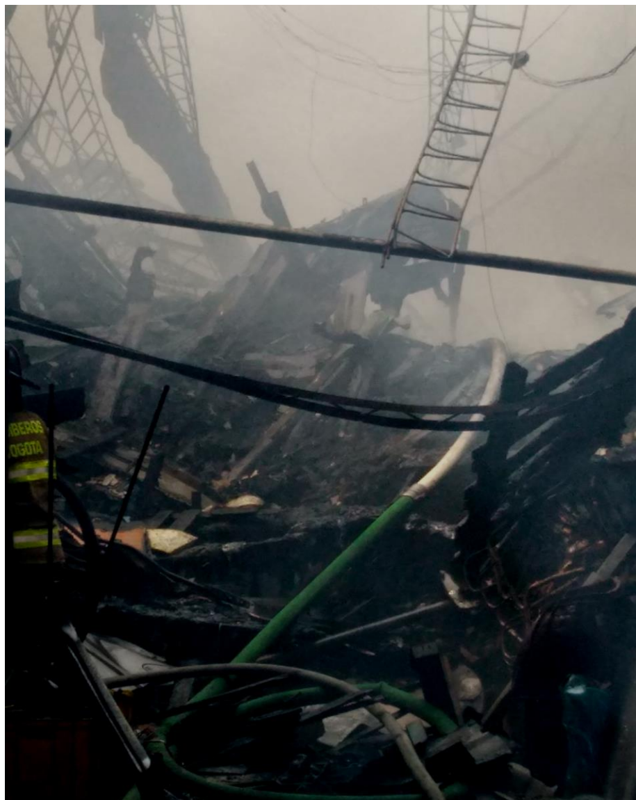
Incendio de la bodega de almacenamiento de repuesto para buses del barrio Carvajal Fuente: Bomberos de la Localidad de Kennedy.
